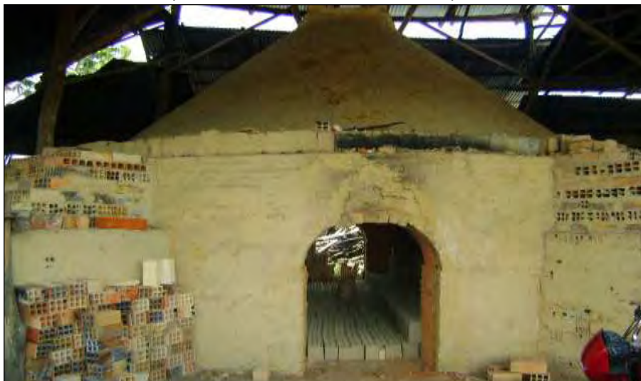
Foto N°020: Inicio de Modificación de diseño de hornos para el quemado de ladrillos de arcilla, para el menor uso de leña como parte del combustible
