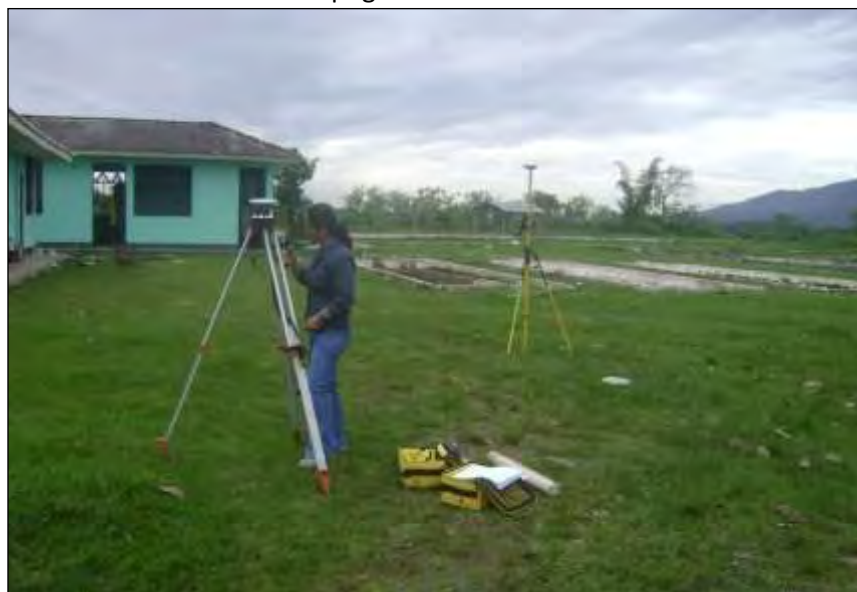
Foto N°027: Levantamiento Topográfico E.P. Marona.
