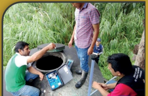
Foto N° 18: Desinfección e instalación de sistema de cloración en el Centro Poblado de Pacayzapa.
