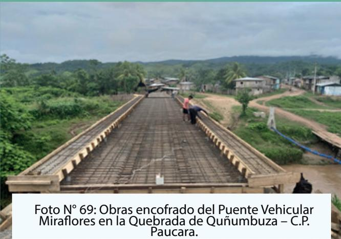
Foto N° 69: Obras encofrado del Puente Vehicular Miraflores en la Quebrada de Quñumbuza – C.P. Paucara.
