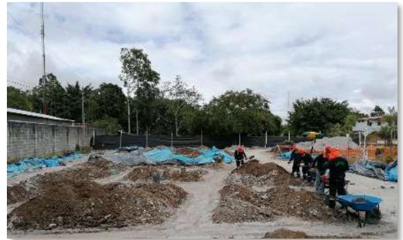
Imagen 1. Proyecto en ejecución
